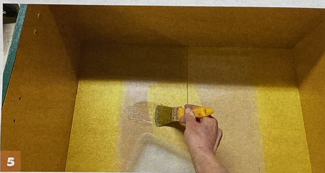
5 Mischen Sie den Tapetenkleister an und bringen ihn mit einem Pinsel oder einer Kleisterbürste flächendeckend auf Rückwand und Seitenwände auf . Kleben Sie dann die Tapete auf.
